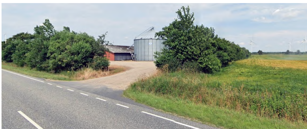
Figur 8.1. Foto af eksisterende oversigtforhold ved afkørsel til Novej 16, der danner adgangsvej til plan- og projektområdet.
