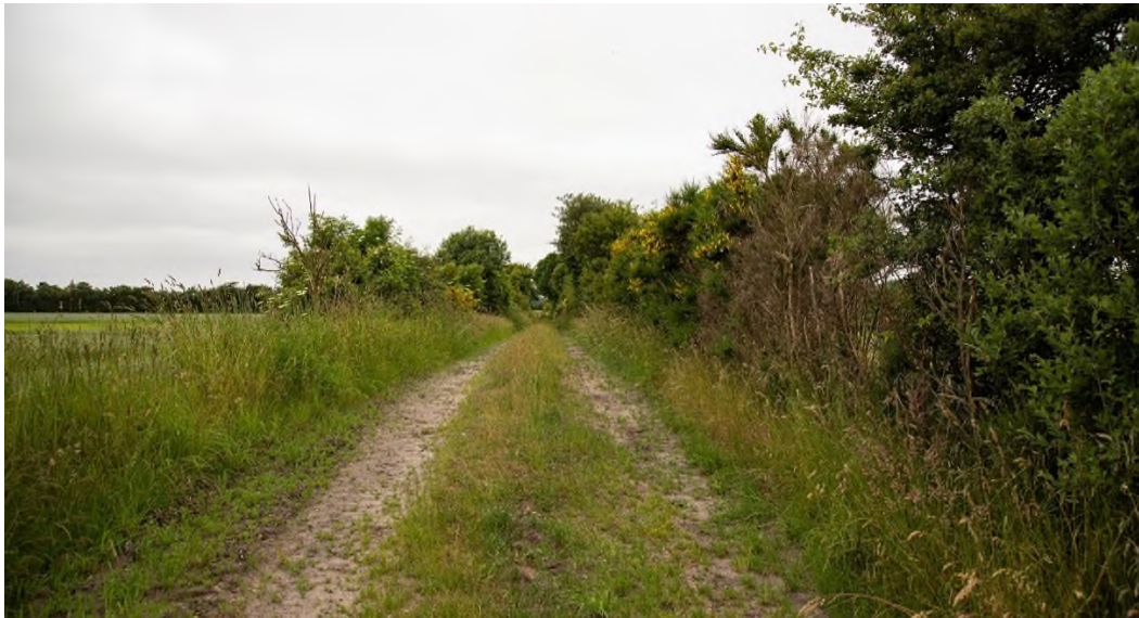
Foto 6.7. Det gamle banetracé for Ørnhøjbanen fra den østligste del set mod vest. Specielt i denne ende opleves tracéet liggende højere i terrænet.
